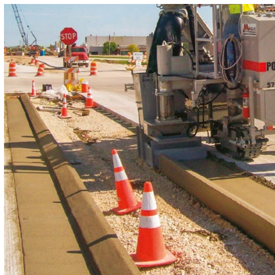
Конусообразный бордюр и желоб, укладываемые поверх дюбелей на стыке дорожного покрытия.
