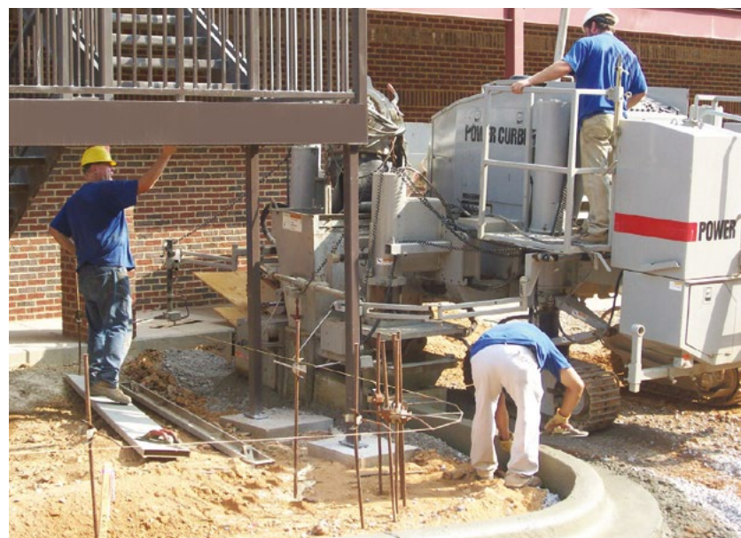
Благодаря высокой маневренности на ограниченном пространстве количество стыковок сведено к минимуму.
