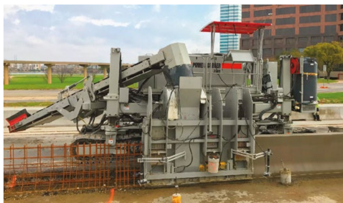
Многофункциональный бетоноукладчик со скользящими формами Power Curbers 7700 устанавливает изменяемый барьер.
