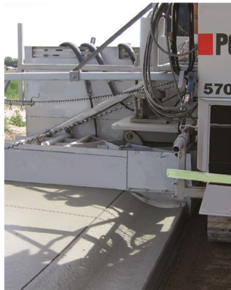
Монолитный бордюр, желоб и тротуар.
