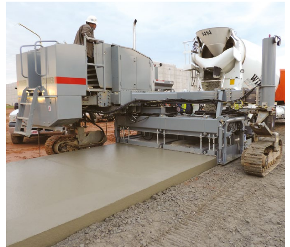
Центральная укладка шириной 3 м. Бетон выгружается непосредственно в бункер, расположенный перед формой укладчика.
