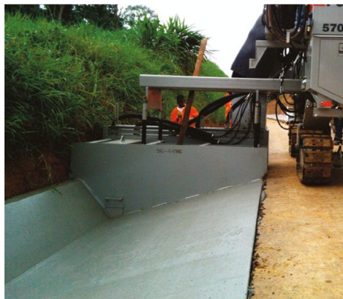
Создание V-образной формы в Экваториальной Гвинее, ширина 2,2 м, глубина 0,45 м, смежная с покрытием с двух сторон.
