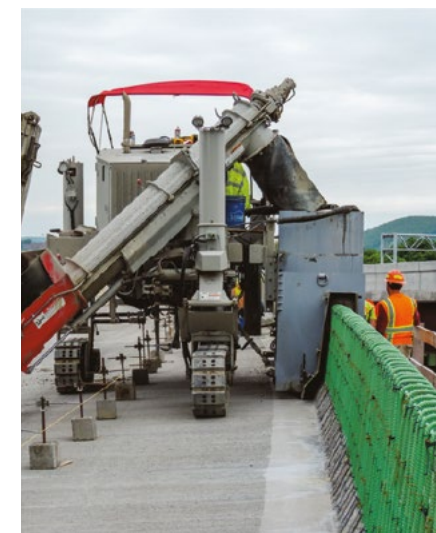
Укладка барьера по арматурному каркасу.
