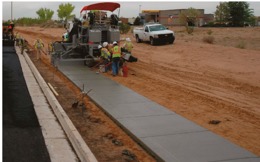
Укладка тротуара 1,8 м.
