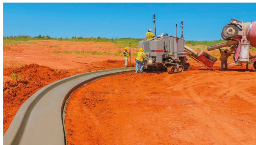
5700-D может работать без копирной струны.
