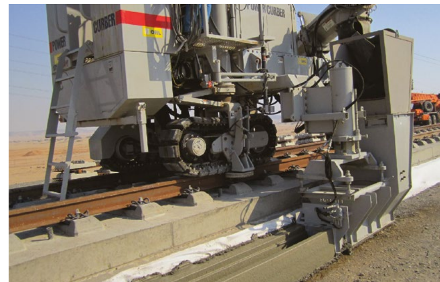
Устройство для высокоскоростной железной дороги в Саудовской Аравии с использованием специальных рельсовых насадок для пропускания через них сетей.
