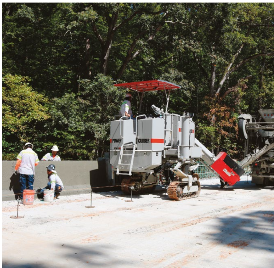
Машина 5700-D-MAX устанавливает перила моста на арматуру. Имеет навес в качестве опции.
