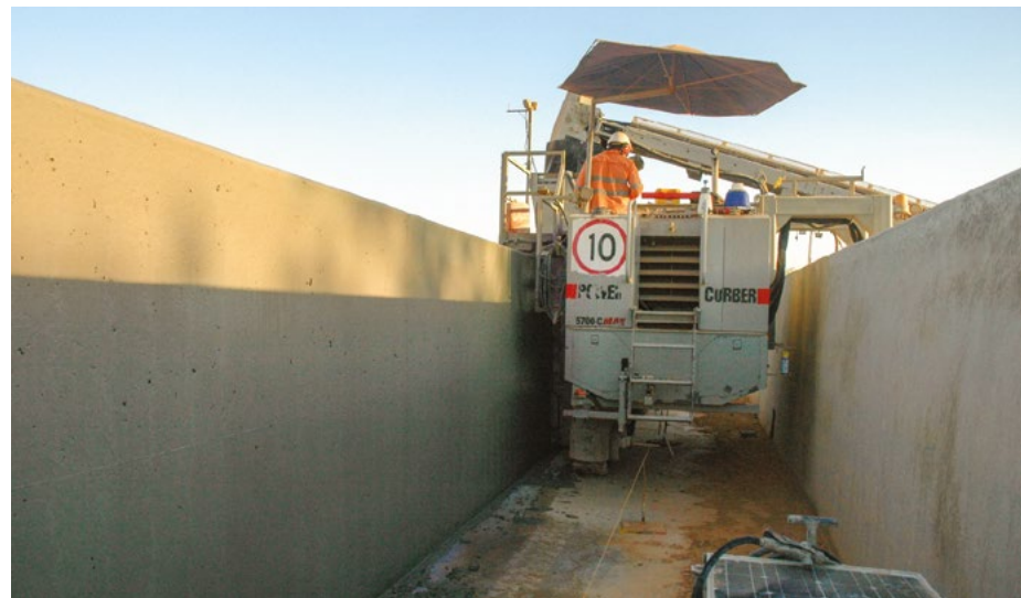
Канал в Австралии, базовая ширина 3,8 м и боковины высотой 2,1 м, (с транспортером, созданным на заказ).
