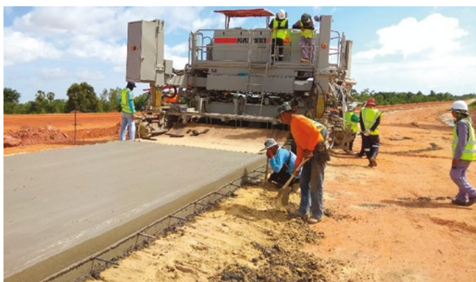
Многофункциональный бетоноукладчик со скользящими формами Power Curbers 7700.
