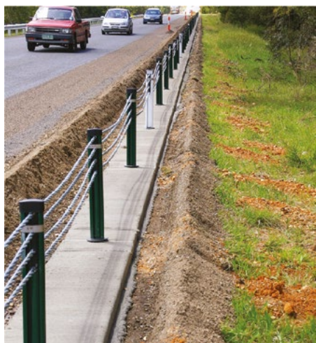
5700-D представляет собой комплексное решение для устройства «противораствительных полос» для канатных барьеров.
