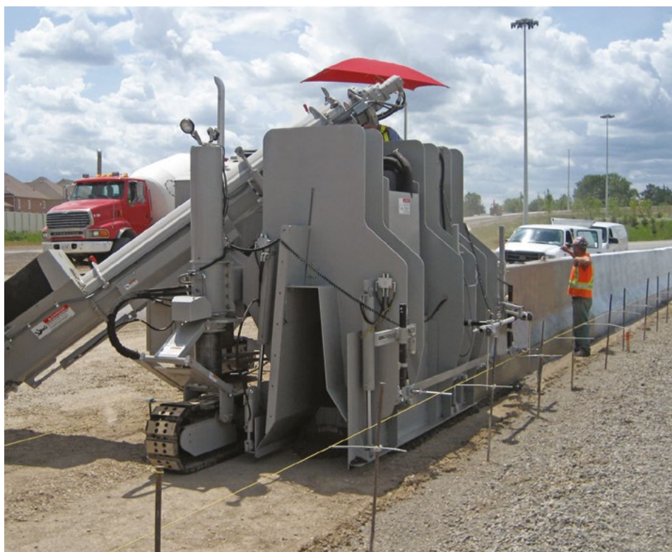
Отливка большого, изменяемого по высоте барьера при помощи 5700-D-MAX.
