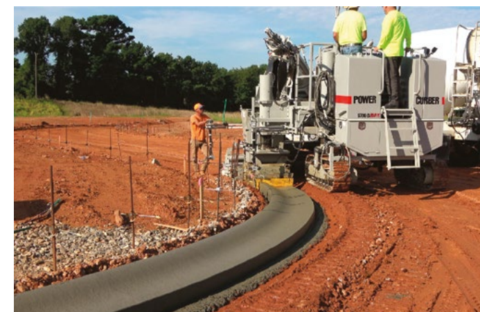
Заднюю опору на 5700-D-MAX можно переместить назад в стандартное положение для устройства бордюров и желобов.
