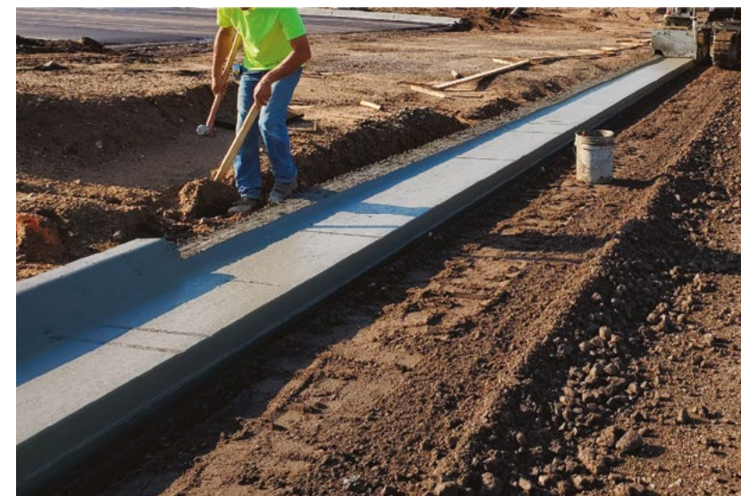
Использование дорожных резцов позволяет экономить бетон и сокращать трудовые затраты. Необходимо немного доработать готовое изделие вручную.
