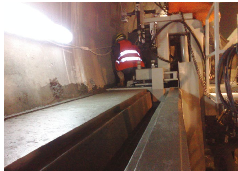
Конструкция платформы и стенок вдоль стены тоннеля в Перу – форма регулируется по высоте и ширине для строительства тоннеля с разным диаметром.
