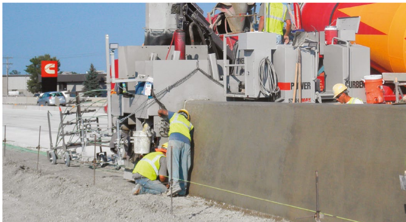
Отливка изменяемого барьера высотой 1,47 – 1,78 м.
