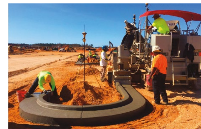
Установка бордюра и водостока при помощи 3D контроля (без копирной струны).
