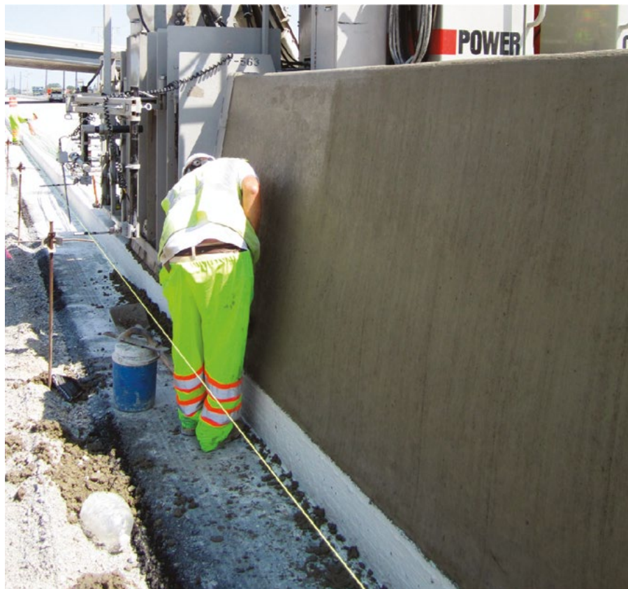
Изменяемый барьер высотой 1,45 м.
