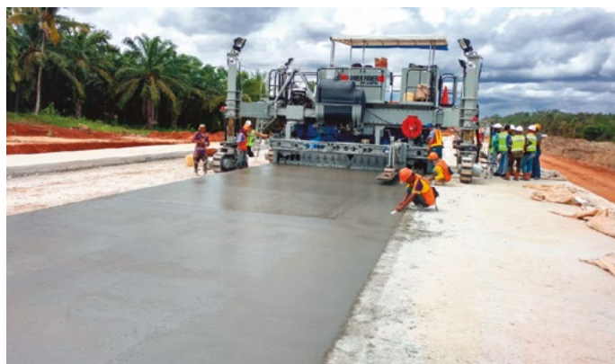
Бетоноукладчик Power Pavers SF-2404 со скользящими формами на 4 гусеницах .
